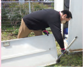
ドアの取り付け作業
