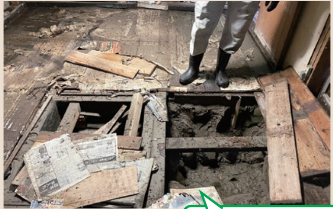
床下の泥を 撤去します
